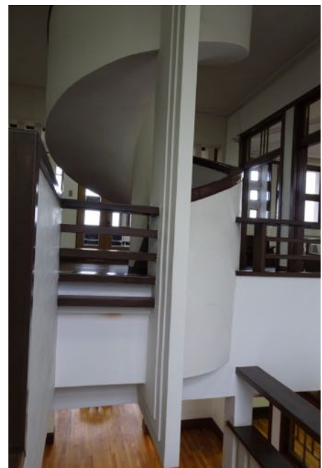
塔屋に通じるらせん階段 ※写真：3点とも角幸博
