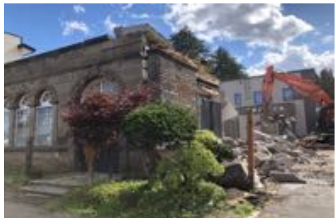
【解体中の様子】
