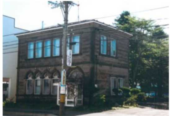
【震災前の建物】
